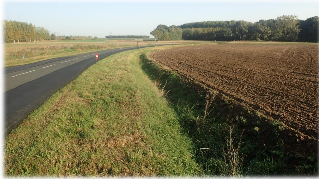
Photo 14 : Fossé de collecte des eaux pluviales le long de la RD 22 au sud du périmètre
