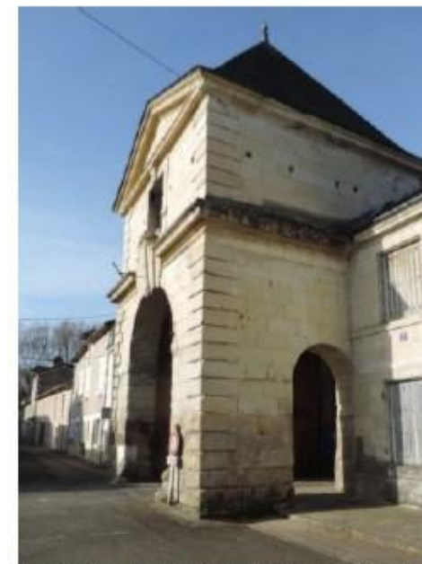
Porte d'entrée Ouest de la ville, insérée dans le rempart
